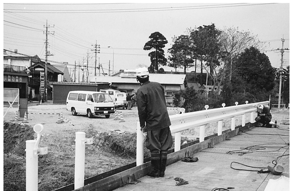
写真 8 防護柵設置状況
