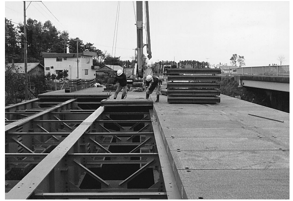
写真 7 覆工板設置状況
