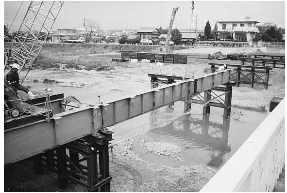
写真 6 上部工架設状況
