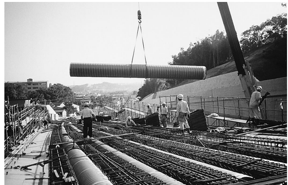
写真 3 円筒型枠設置状況
