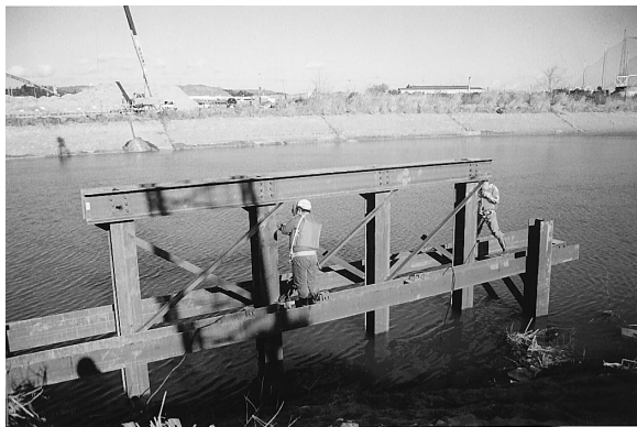
写真 5 定規材設置状況
