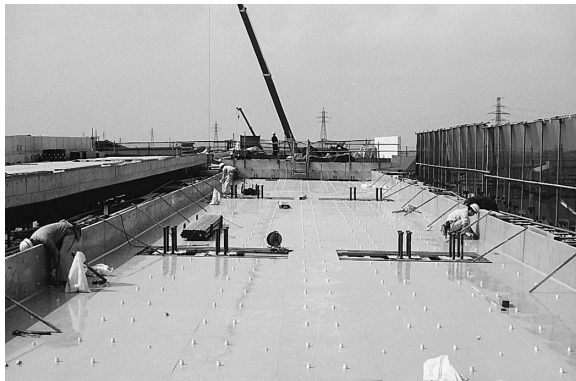
写真 1 型枠設置状況
