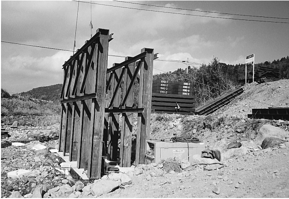
写真 3 直接基礎橋脚
