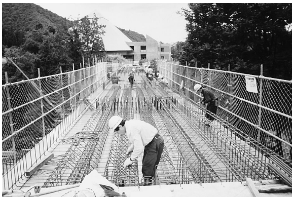
写真 2 鉄筋組立状況
