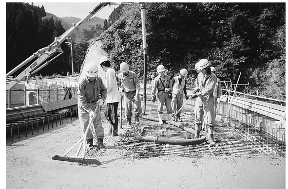
写真 4 コンクリート打設状況
