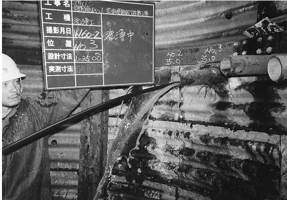
写真 1 孔内洗浄（井内作業）
