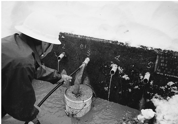
写真 2 孔内洗浄（井外作業）
