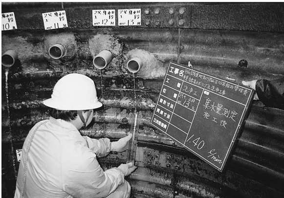
写真 3 水量計測（洗浄後）
