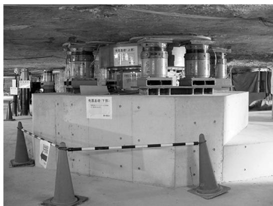
写真 4 仮受けジャッキ撤去前
