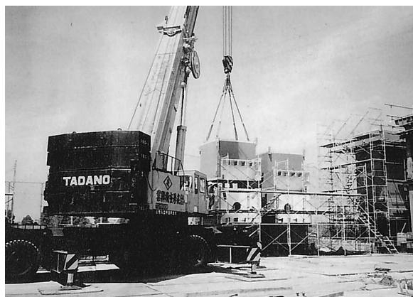
写真－２ 地組作業
