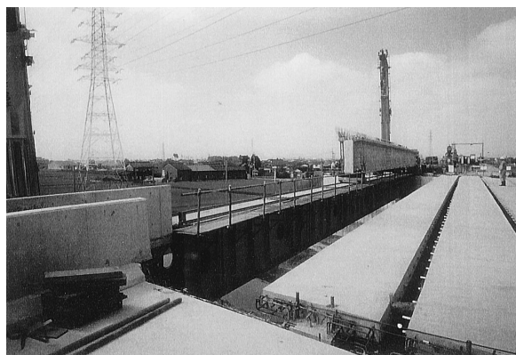
写真-2 架設桁による架設状況
