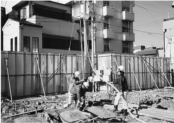
写真 1 ウェルポイント打込状況
