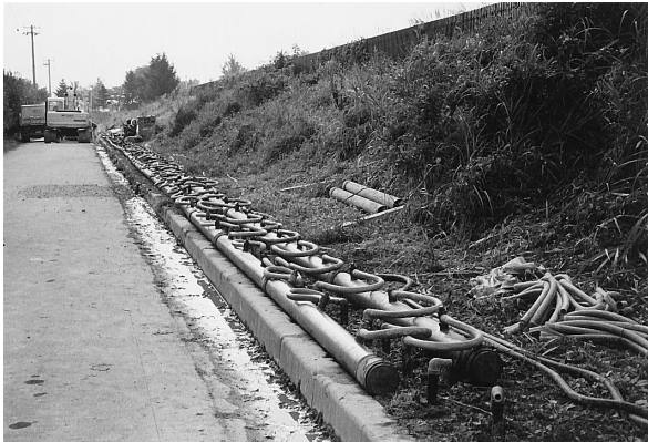
写真 2 ウェルポイント設置状況
