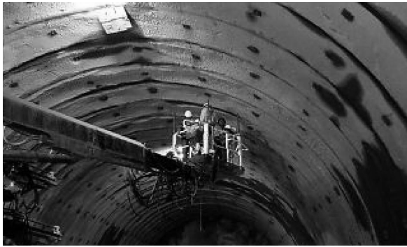
西粟倉トンネル現場見学会
