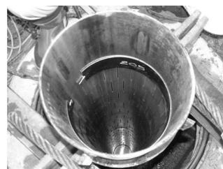
写真 10 補修材装着状況
