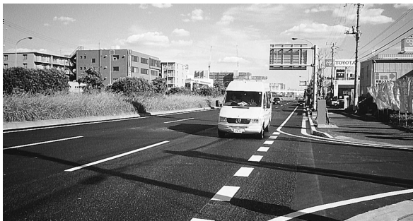
舗装路面騒音測定車による騒音測定
