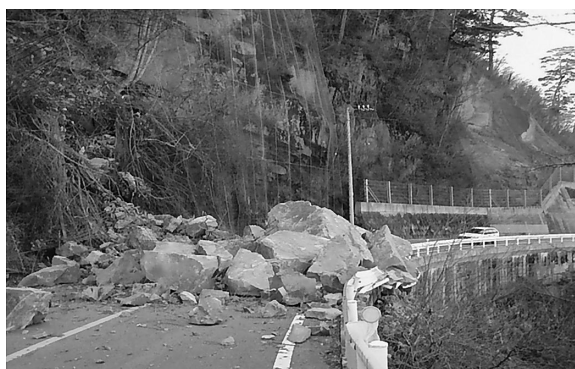
写真 2 主要地方道西条久万線（石鎚スカイライン）
