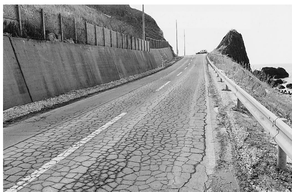
写真 1 一般国道国道338号佐井村磯谷地内（青森県）
