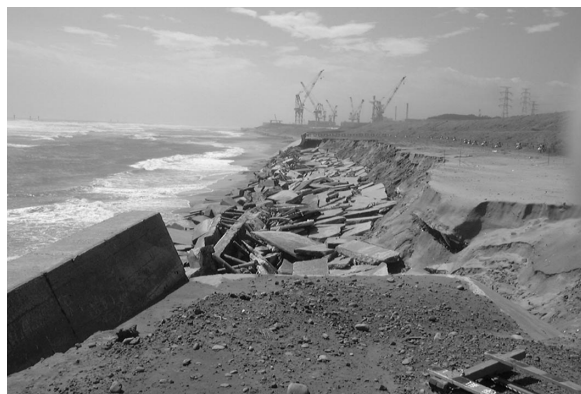
写真 4 御前崎海岸（静岡県御前崎町白羽地先）
