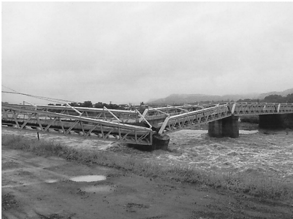
写真 6 市道大屋丸子線上田市大石橋（長野県）
