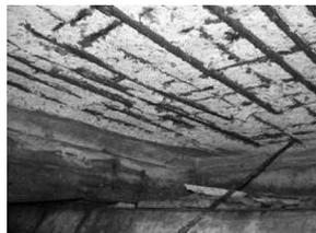
塩害により鉄筋がむき出し
