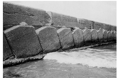
左：現在の小樽港と北防波堤 中央：高波に耐える北防波堤 右：コロンボ港南防波堤の斜塊（北海道総合研究所提供）
