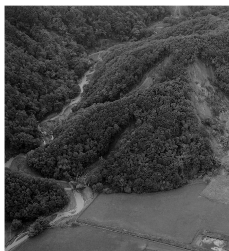
写真 3 河道に達する崩壊地
