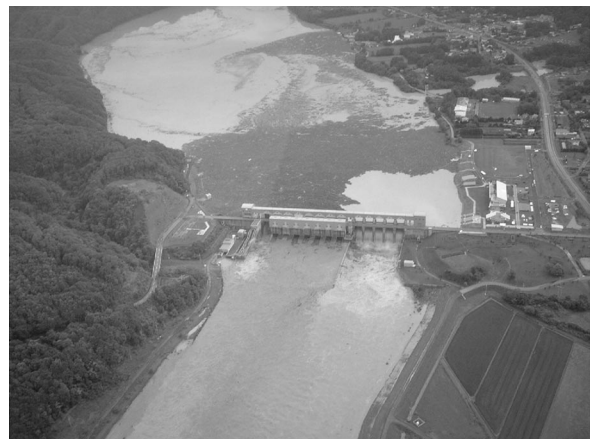
写真 1 二風谷ダムで捕捉した流木
