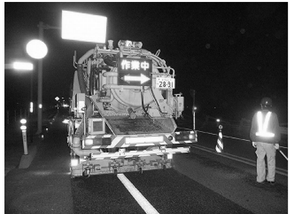
写真 1 排水性舗装清掃作業
