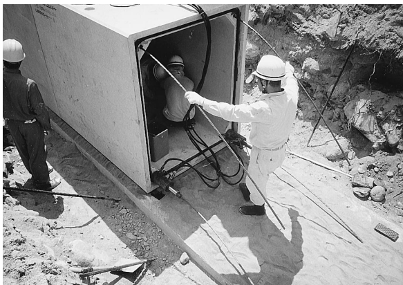
写真 2 ボックスカルバート
