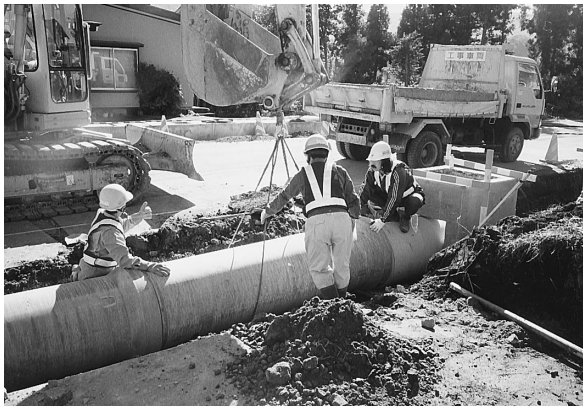
写真 1 ヒューム管 B 型管 (ソケット管)
