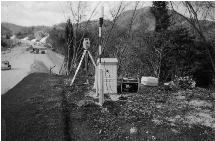
写真 1 試験施工状況
