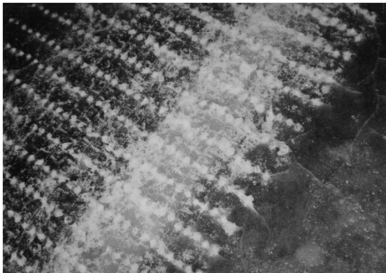
写真 5 粗面施工後の路面状況
