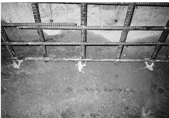
写真 4 アンカー定着状況
