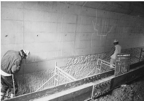
写真 3 下地処理(チッピング)状況
