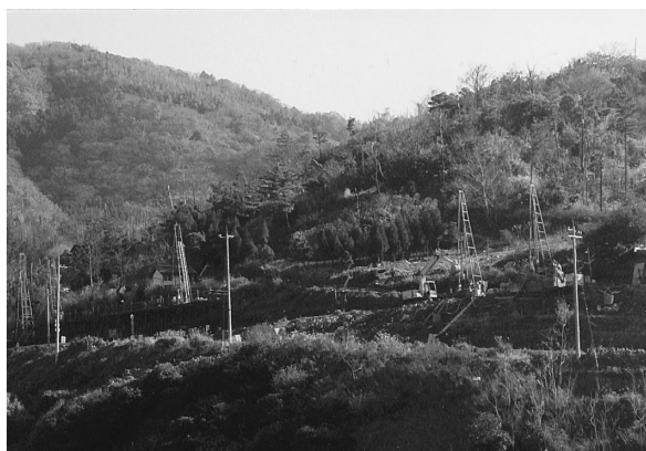
写真 1 施工現場の状況
