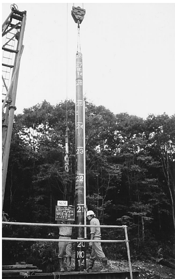
写真 6 建て込み状況
