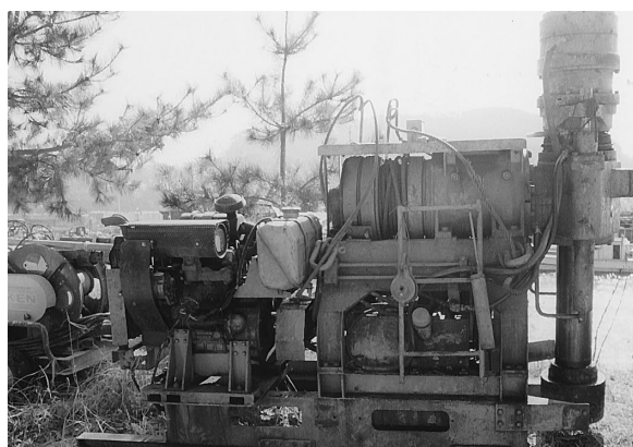
写真 4 大口径ボーリングマシンの掘削状況
