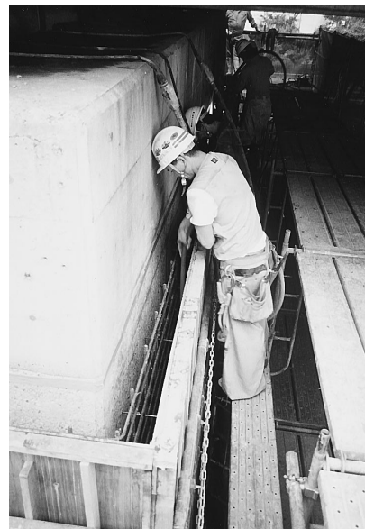
写真 7 コンクリート打設
