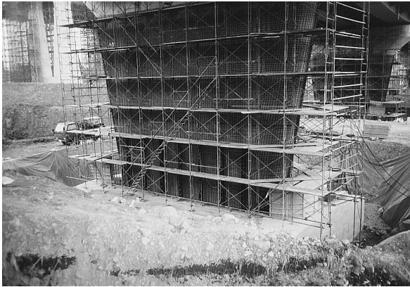
写真 2 足場設置状況
