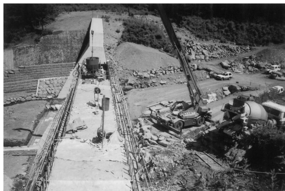
写真-1 ラフテレーンクレーン+コンクリートバケットによるコンクリート投入作業
