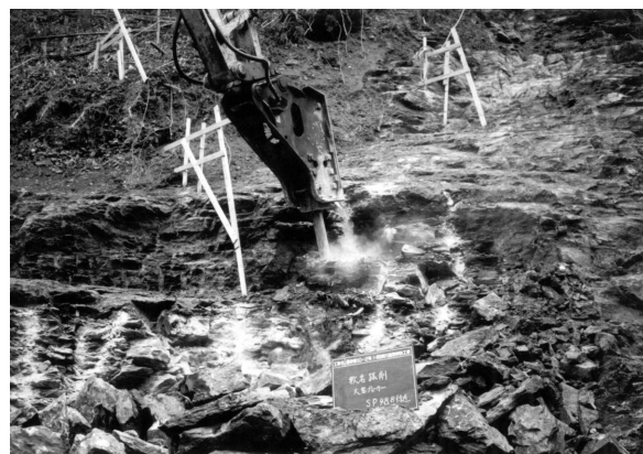
写真-4 岩石掘削（機械）
