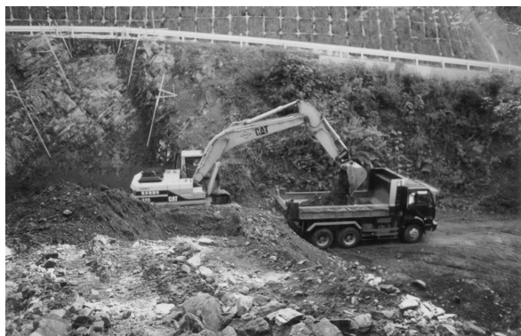
写真-1 バックホウ掘削積込
