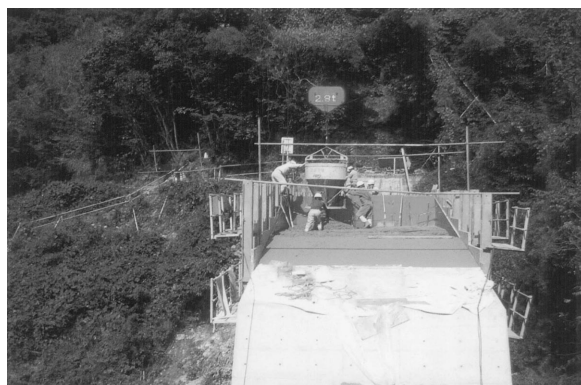
写真-3 ケーブルクレーンによるコンクリート打設
