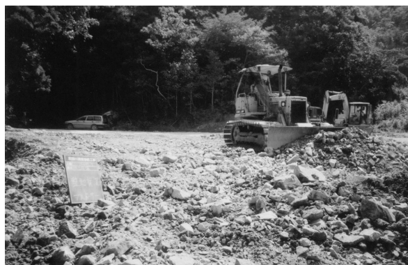
写真-3 ブルドーザ掘削押土
