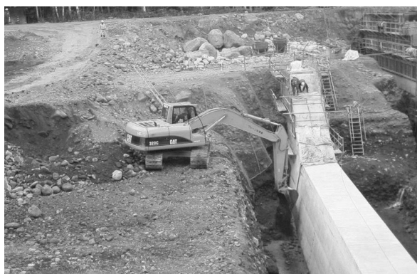
写真-2 バックホウ埋戻し
