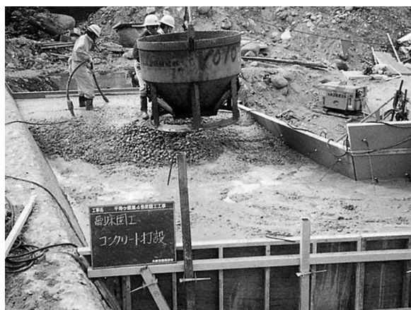
写真-2 コンクリート打設状況
