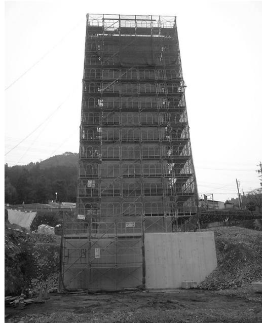
写真 5 手摺先行型枠組足場設置状況
