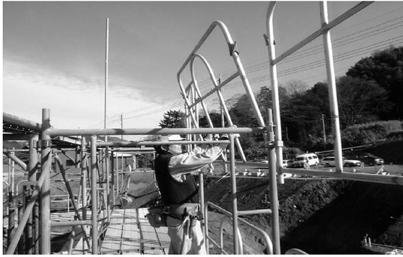
写真 1 手摺先行型枠組足場設置作業状況
