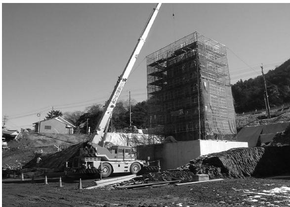
写真 3 手摺先行型枠組足場設置作業状況
