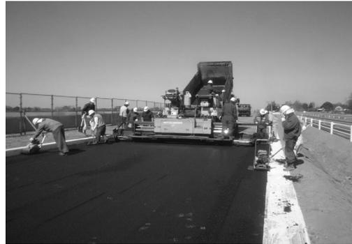
写真 1 アスファルト舗装工 敷均し作業状況
