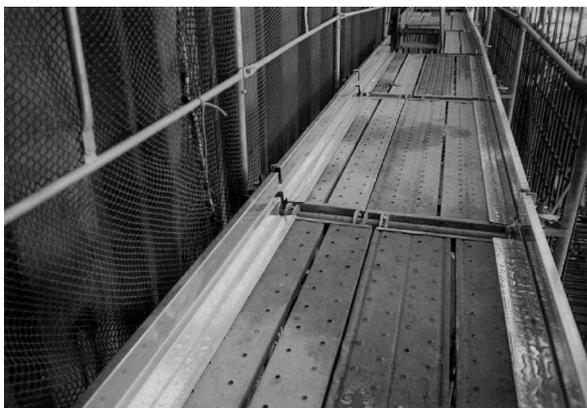
写真 4 手摺先行型枠組足場設置状況
