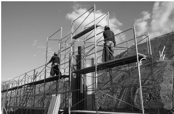
写真 2 手摺先行型枠組足場設置作業状況
