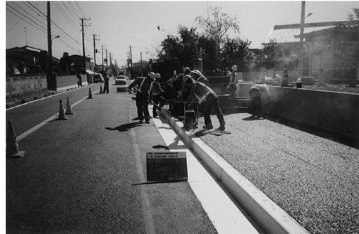
写真 2 透水性アスファルト舗装工 敷均し作業状況
