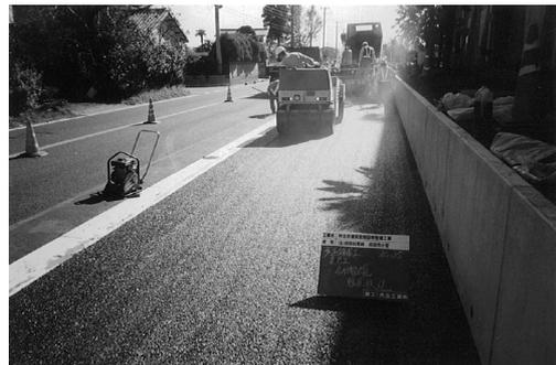
写真 3 透水性アスファルト舗装工 締固め作業状況
