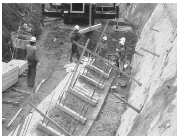
写真 2 組立式の据付状況
