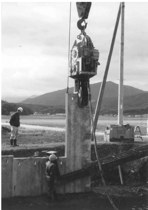
写真 2 パイプロハンマによる施工状況
