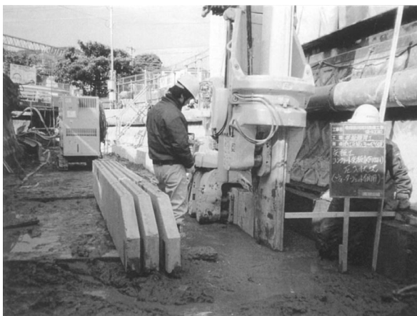
写真 3 油圧式杭圧入機による施工状況
