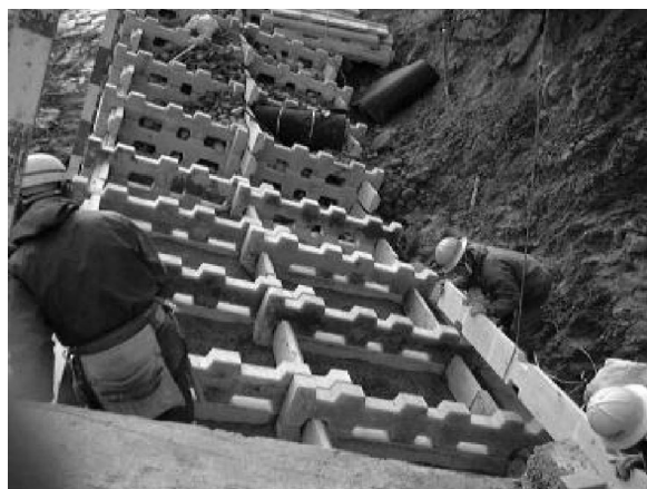
写真 1 組合せ式の据付状況
