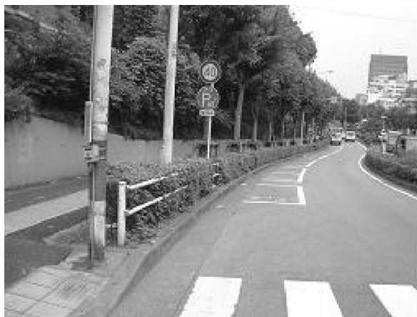
写真 1 植樹帯により歩行者の横断防止機能が確保されているため、横断防止柵は必ずしも必要ない
