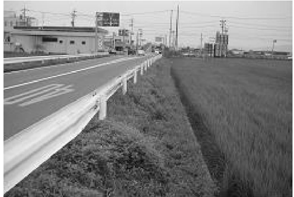
写真 5 高低差が低い場合には、路外逸脱を防止する車両用防護柵の必要性は低い
