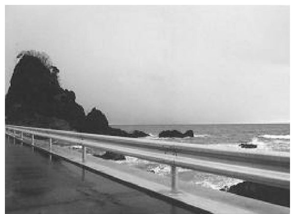
写真 4 透過性が低く外部への眺望を阻害している
