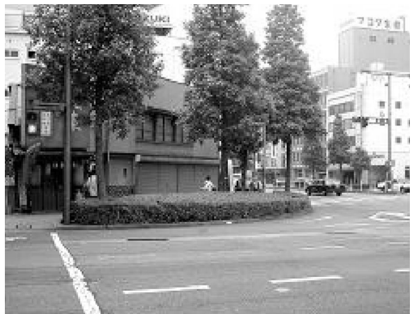
写真 6 歩行者の巻き込み防止を目的として設置される防護柵は、縁石や駒止、高さの低い植樹帯で代替可能
