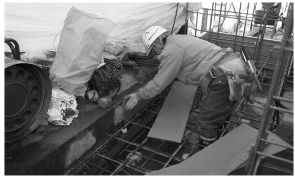
写真 3 目地板施工中
