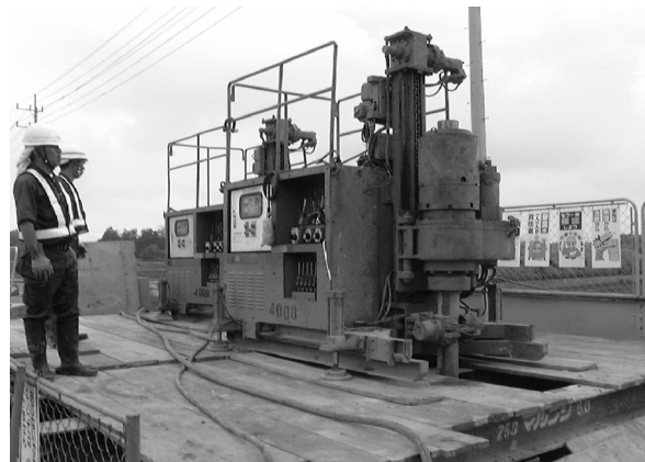
写真 1 単管工法施工状況 (左上) 写真 2 二重管工法施工機械 (左下) 写真 3 三重管工法施工機械 (右)
