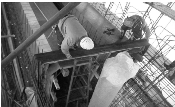
写真 2 止水板施工中
