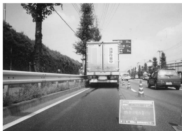
写真 1 機能回復作業状況
