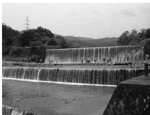
写真 3 地蔵原堰堤（大正14年完成） （選奨土木遺産・登録有形文化財）
