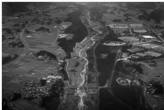
写真 1 荒川流域の旧霞堤、水防林（荒川を上空から望む）
