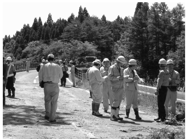
写真 5 現地の応急復旧体制の把握
