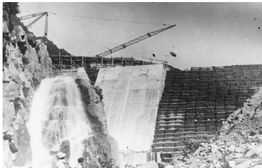
写真 4 平成7年 工事設備状況
