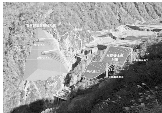
写真 7 白岩砂防えん堤補強対策計画
