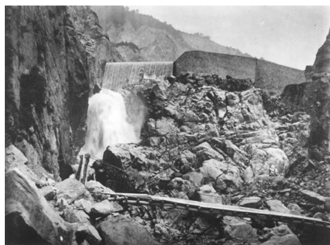
写真 2 完成目前の県営湯川第一号砂防えん堤
