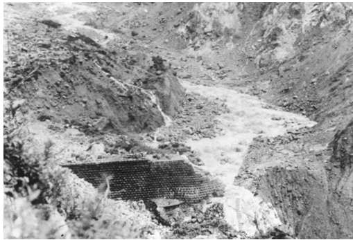
写真 3 大正11年 洪水で破壊された湯川第一号砂防えん堤
