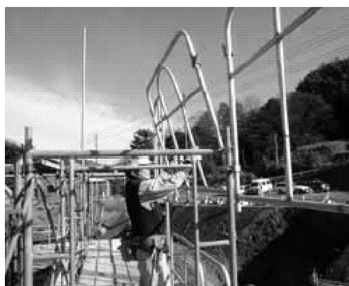
写真 2 手すり設置作業
