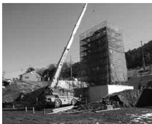
写真 3 クレーン作業
