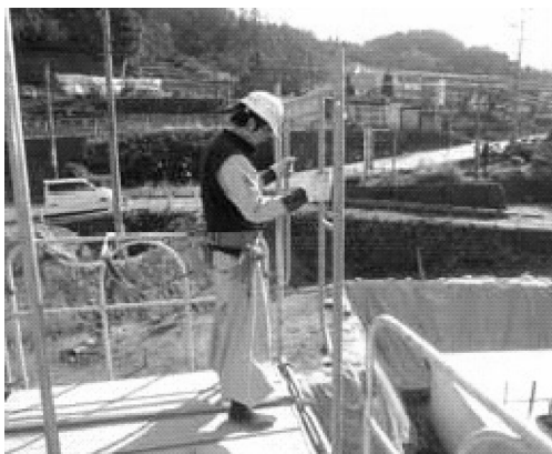
写真 1 建枠組立作業
