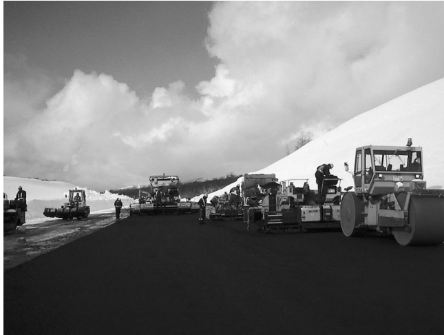
H17 一般国道5号黒松内町黒松内舗装工事 (北海道開発局)
