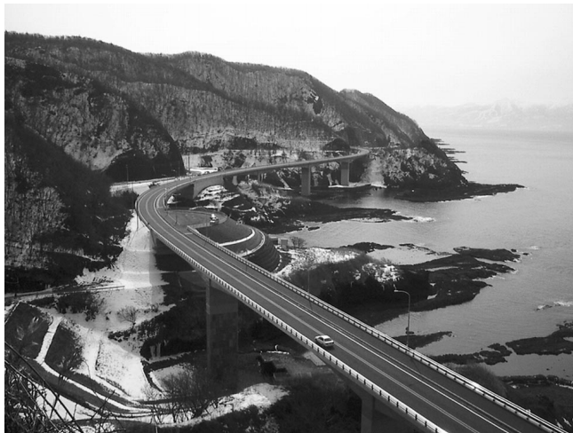
H18 一般国道229号神恵内村祈石舗装工事 (北海道開発局)
