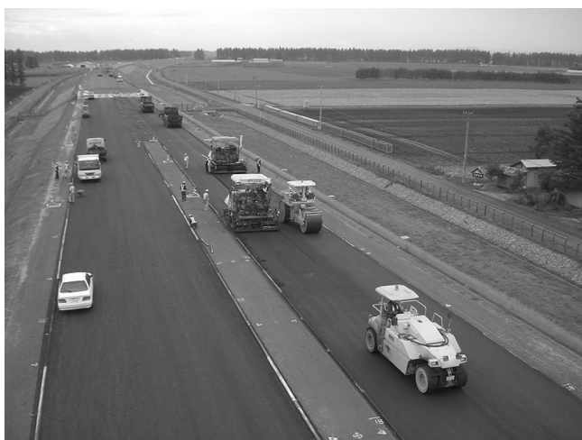
H19 帯広広尾自動車道帯広市幸福舗装工事 (北海道開発局)
