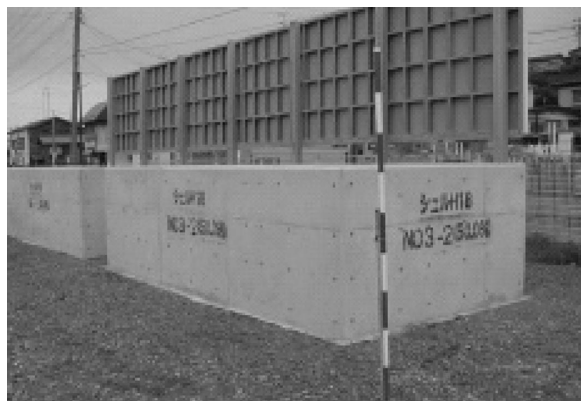
根固めブロック
