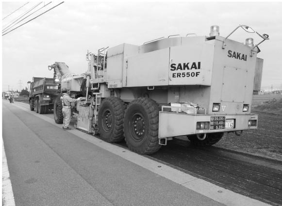
写真 1 舗装路面の切削作業
