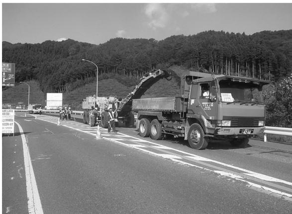
写真 2 切削廃材の積込作業
