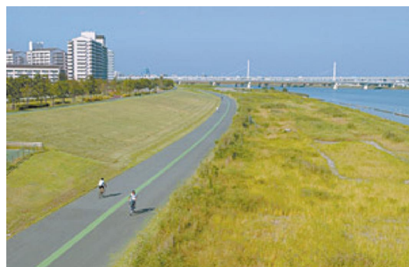
写真-3 緊急用河川敷道路
