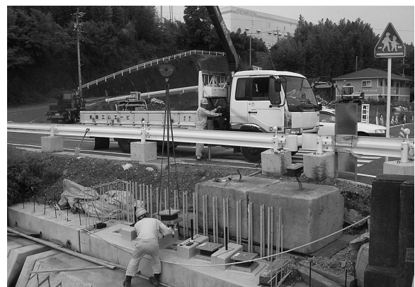
写真 6 ゴム製支承据付
