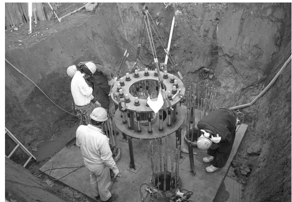
写真 5 アンカーフレーム据付
