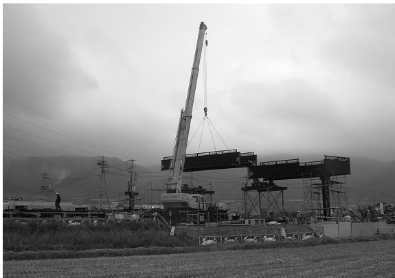
写真 2 歩道橋の架設（移動式クレーン・ステージング工法）
