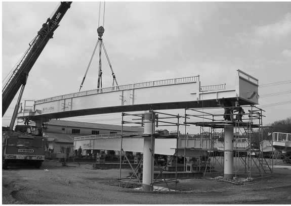
写真 1 歩道橋の架設（移動式クレーン工法）
