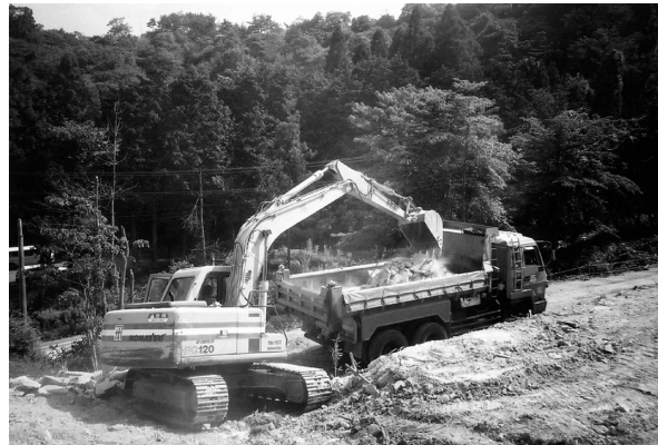
写真 4 集積・積込作業状況
