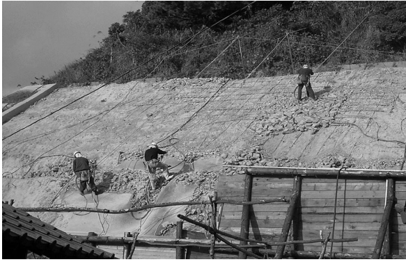
写真 1 とりこわし状況（人力によるとりこわし）
