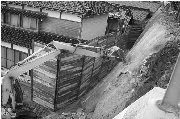
写真 2 とりこわし状況（バックホウによるとりこわし）
