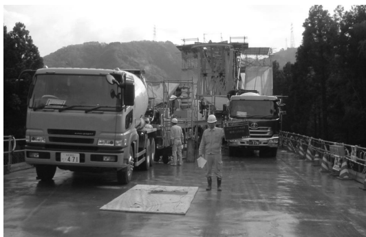
写真 5 ポンプ車2台による起終点同時施工
