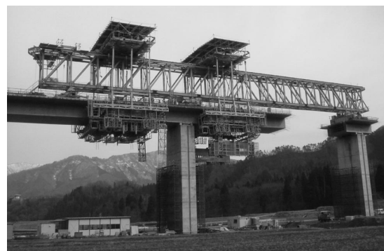
写真 4 P&Z 装置移動状況
