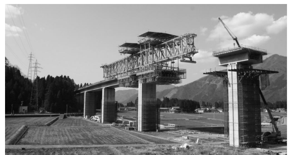
写真 1 吉峰高架橋施工状況全景
