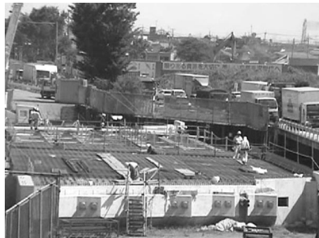
鴨川大橋 施工中の 全景
