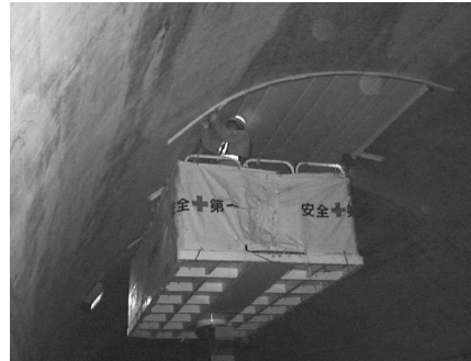
写真 1 面導水 施工状況
