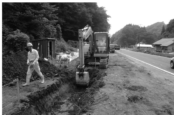
写真 1 床掘施工状況
