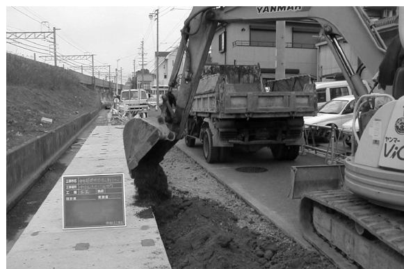
写真 2 埋戻し施工状況
