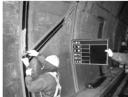
写真 2 線導水 施工状況
