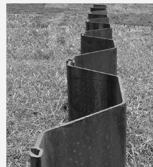
写真 1 ハット形鋼矢板900〔10H型〕施工後状況
