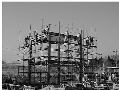
躯体基礎コース
