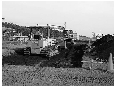
建設機械運転基礎コース
