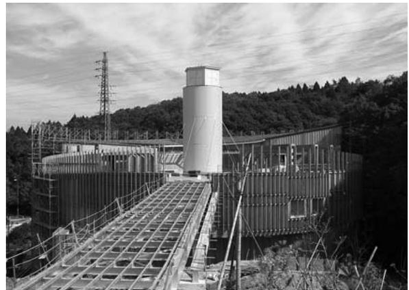
写真 8 瀬戸日本館：鉄骨造4階建，延べ3,000m<sup>2</sup>
