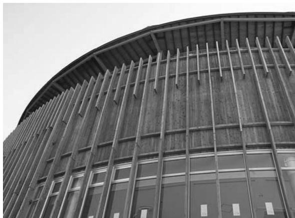
写真 10 準耐火性能を有する外壁の木質パネル
