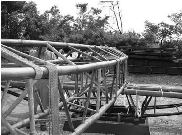
写真 2 竹トラスの試験組み立て状況
