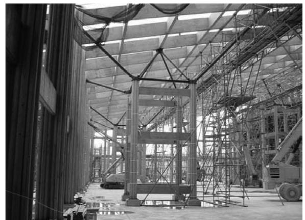
写真 5 組み柱の施工状況
