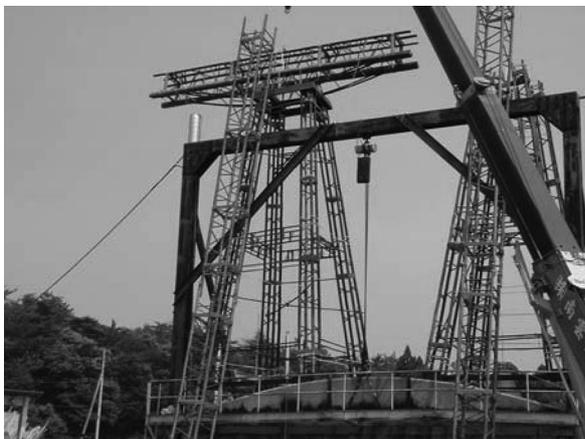
写真 3 竹トラスのモックアップ状況
