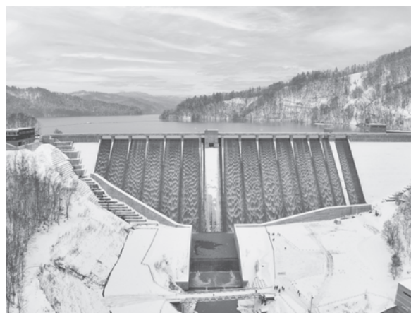
写真－3 試験湛水時の越流の様子
