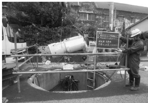
写真－2 低耐荷力泥土圧（先導体据付工）の施工状況
