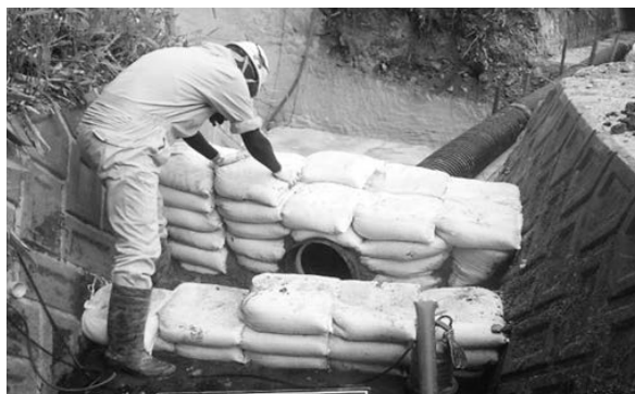
写真-7 土のう積立作業状況
