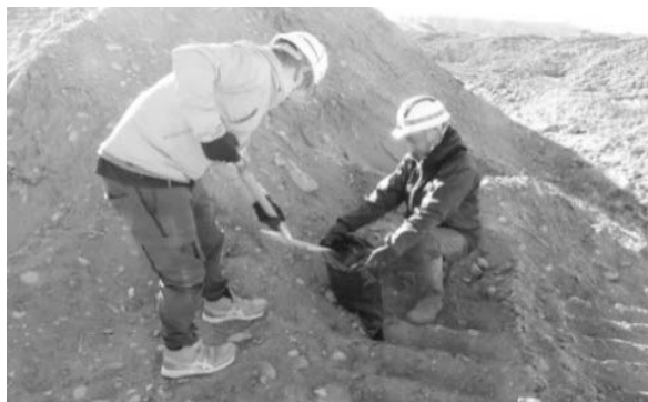
写真-6 土のう製作作業状況
