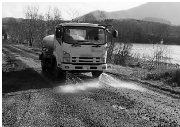
写真－8 散水作業状況
