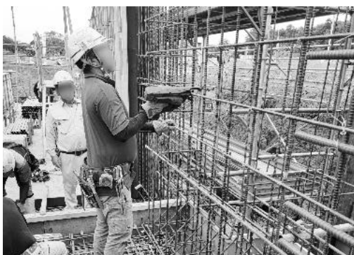
写真－２ 組立作業状況①
