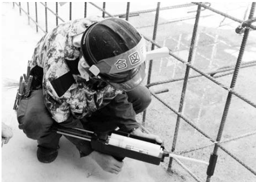
写真－5 機械式継手（グラウト）作業状況
