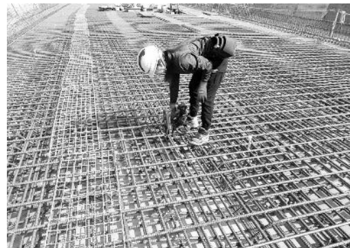
写真－３ 組立作業状況②
