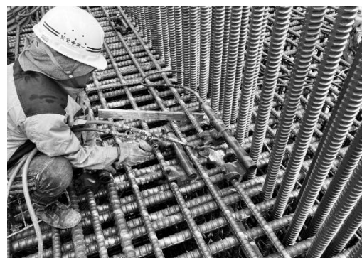
写真－４ ガス圧接継手作業状況
