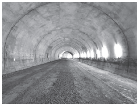
写真－4 静岡県側坑内の覆工コンクリート完了
