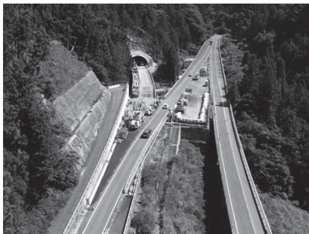
写真－1 静岡側坑口の全景
