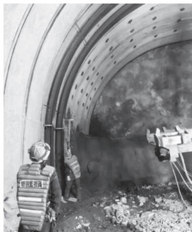
写真－3 二重支保工の施工状況
