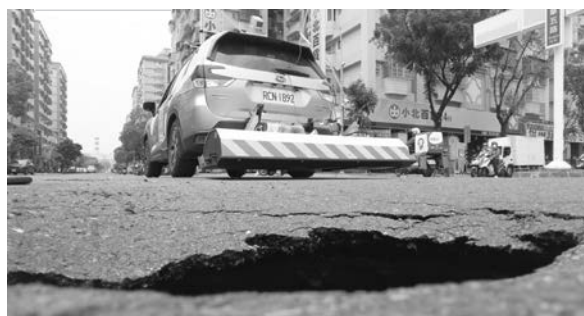
写真-3 陥没箇所周辺を調査する「スケルカー V TM 」
