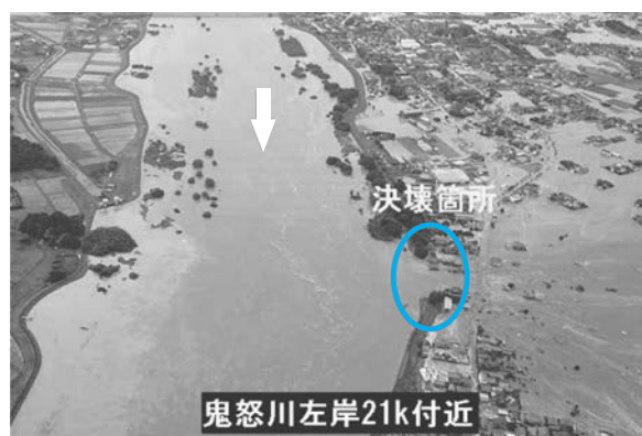
写真－1 関東・東北豪雨で茨城県常総市の鬼怒川の堤防が決壊（出典：国土交通省）
