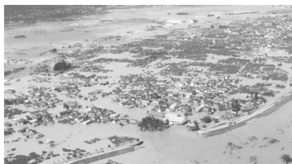
写真－2 信濃川水系千曲川（長野県長野市）の被災状況（出典：国土交通省）
