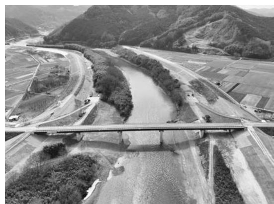
写真－1 激特事業による肱川の堤防整備（令和 6 年度末完成）
