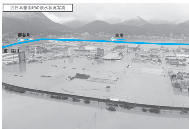
写真一 2 大洲市東大洲地区浸水状況 (平成 30 年 7 月西日本豪雨)
