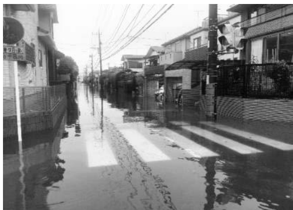
写真－1 令和 5 年 6 月台風第 2 号による浸水被害の様子（越谷市弥栄町地区）
