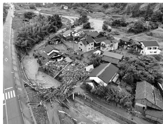
写真－2 横断工作物で大量の流木が捕捉（塚田川）
