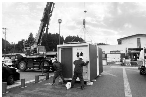
写真-3 道の駅「あなみず」へ派遣された防災用コンテナ型トイレの設置の様子
