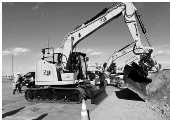
写真－5 法に正対しなくても施工可能なチルトローテーター
