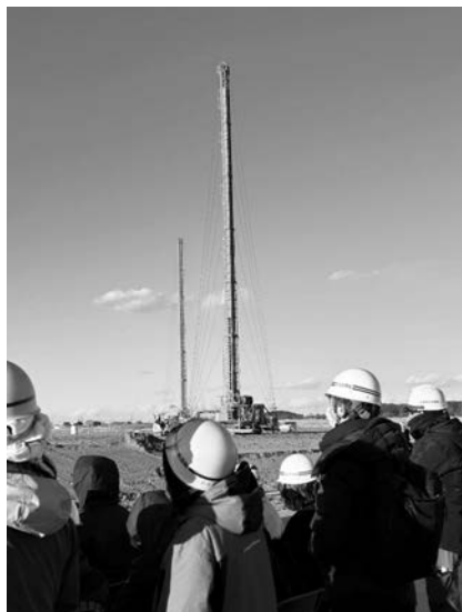
写真-1 プレファブリケートドバーチカルドレーン（PVD）打機
